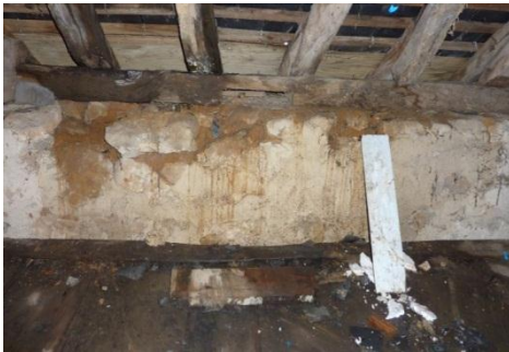
Endommagement de la charpente et des articles stockés dans le grenier du fait d'infiltrations des eaux de pluie. Cause : Envol d'une partie de la toiture lors d'une tempête
